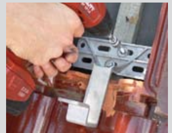
Dachhaken auf Sparren verschrauben
