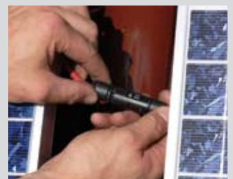
Verkabeln der Module
