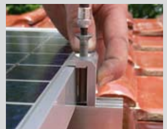
Endklemme montieren
