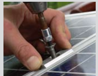
Modulklemmen im Gewindekanal verschrauben
